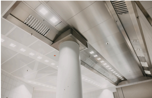
Schallabsorbierende Deckenpaneele bei Nestlé in Frankfurt © ABGEDREHT
